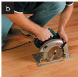
À l'aide d'une scie circulaire ou d'une toupie, couper la lamelle sur toute sa longueur à environ 1/2" de chaque côté des bordures. Ajustez la profondeur de coupe en fonction de l'épaisseur de la lamelle. Pour un plancher collé, effectuez plusieurs coupes rapprochées afin de séparer la lamelle en sections réduites.
