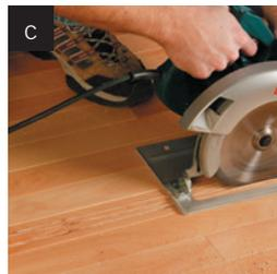
Effectuez une coupe en diagonale au centre de la lamelle d'une extrémité à l'autre des incisions réalisées à l'étape précédente (plus d'une coupe peut être nécessaire lorsque la lamelle est collée).
