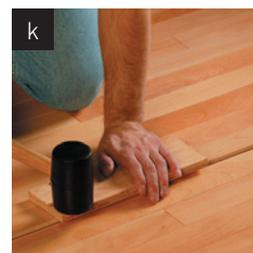
Positionnez la lamelle en place à l'aide d'un maillet de caoutchouc et d'un bloc de bois.
